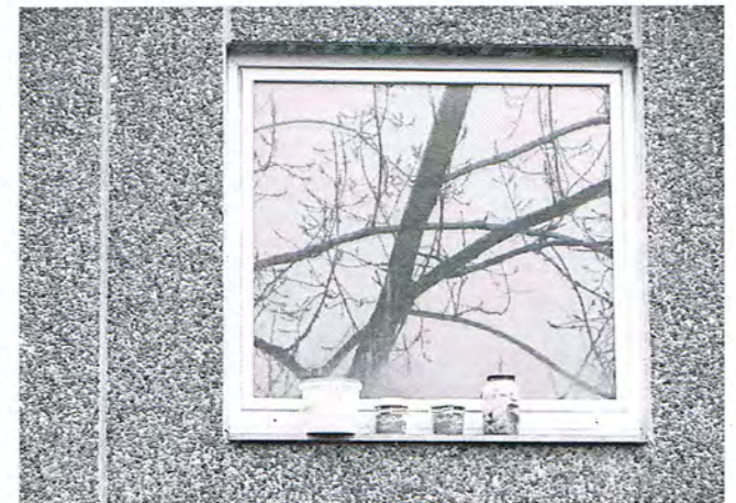
Nach außen verlagert: Auch das Fensterbrett wird genutzt.
